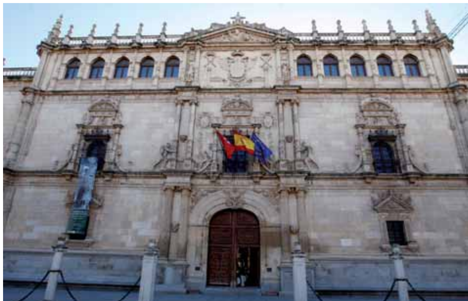
Fachada principal del Rectorado alcalaíno, edificio emblemático, cuna del proyecto universitario del consejero de Isabel la Católica, hoy Patrimonio de la Humanidad.
