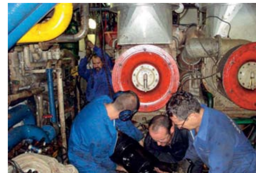
Servicio de máquinas trabajando en una reparación.
