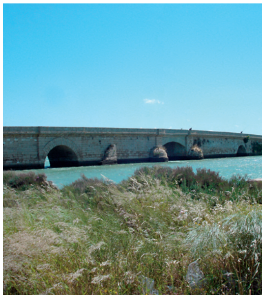
Puente Suazo (San Fernando, Cádiz).
