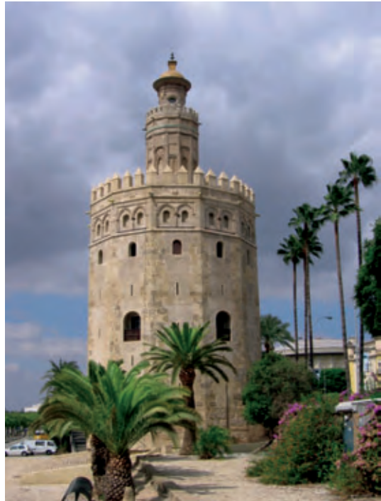
Torre del Oro, Sevilla.
