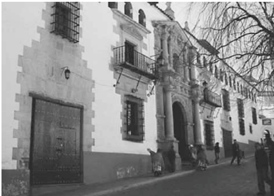
Fachada principal de la Casa de la Moneda. (Foto: Casa de Moneda de Potosí).
