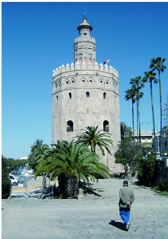
Después de la restauración de 2004-05.
