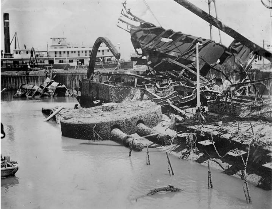
Achique del cofferdam . (Fotografía facilitada por el autor)
