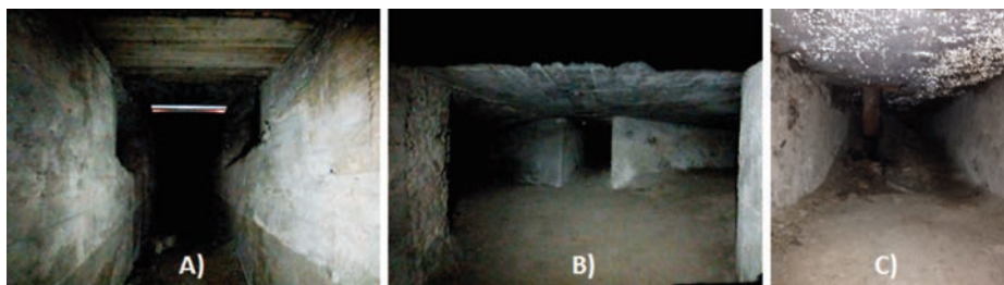
Figura 3. Imágenes detalle del túnel: A) Pasillo central y ramificaciones laterales; B) Trifurcación al final del túnel central, y C) Evidencias de condensación en el interior de una de las ramificaciones laterales.
