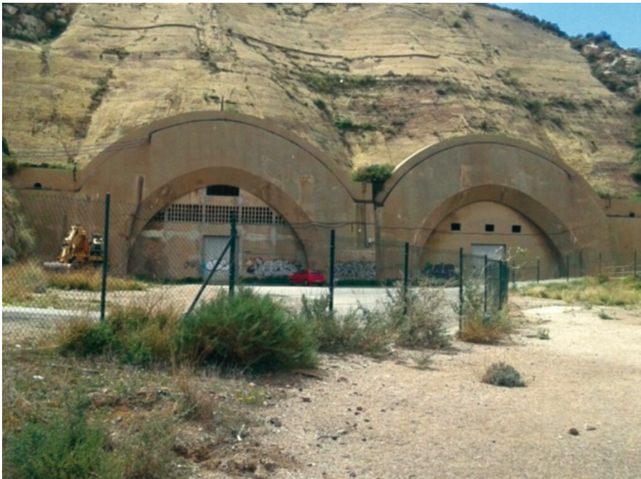
Entrada a los túneles de Espalmador Grande.
