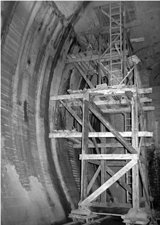
Pared lateral del túnel núm. 1. (Foto: Navantia).
