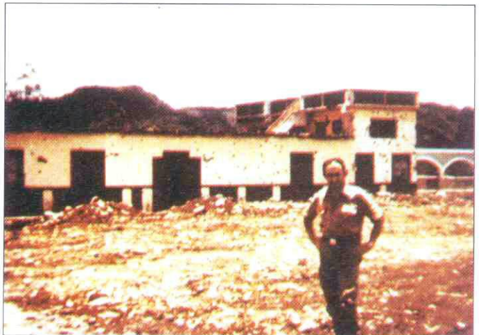
Vista externa del edificio que sirvió para alojar el hospital español, antes de su acondicionamiento.
