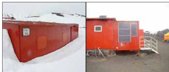
Figura 6. Enfermería «Cap. Médico Ramón y Cajal». Sistema de placas solares.
