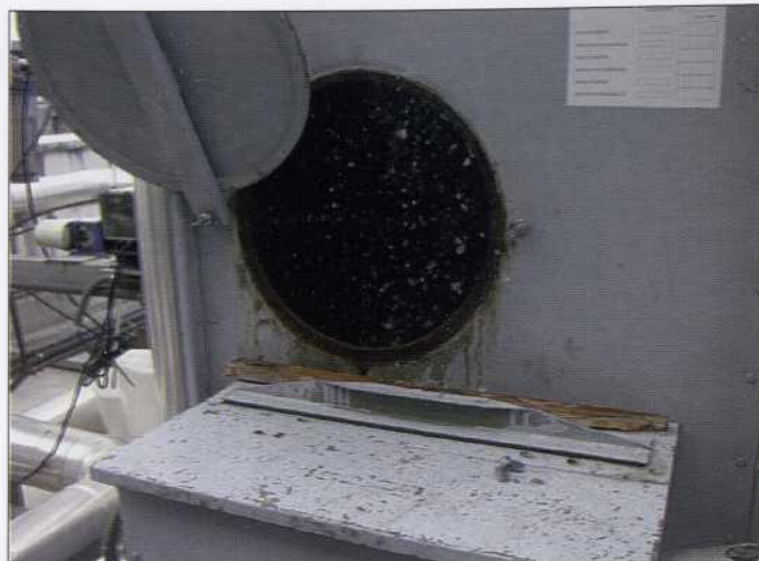
Fig. 3. Apertura de una torre de refrigeración para su inspección.
