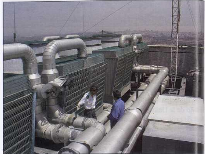
Fig. 1. Capitán Veterinario realizando una inspección de torres de refrigeración
