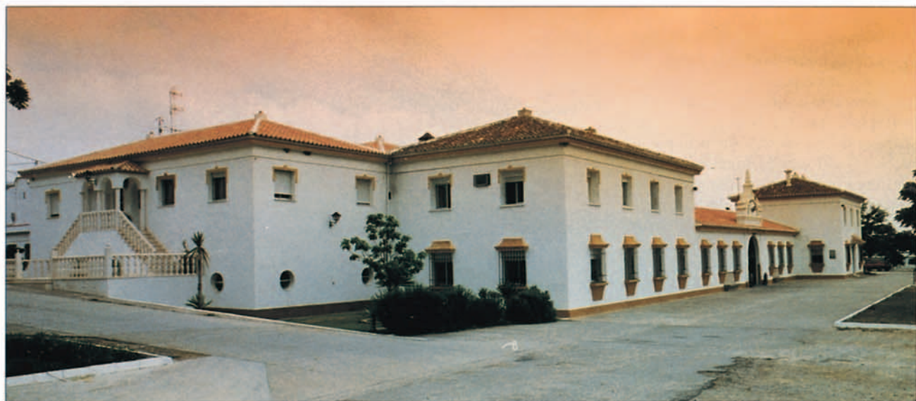
Vista parcial del Acuartelamiento.
