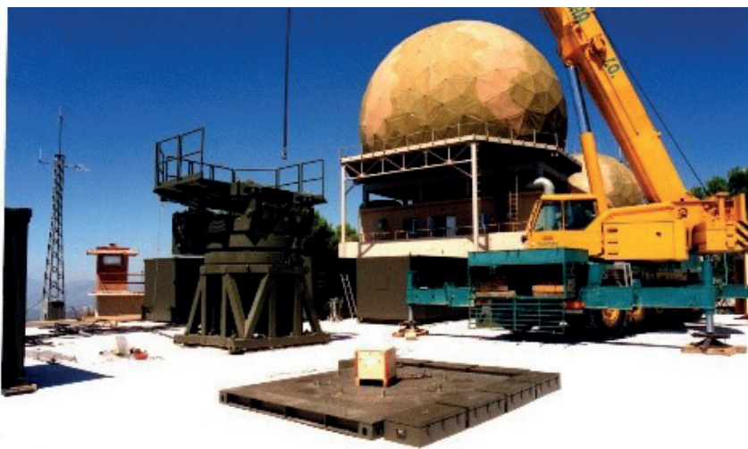
Instalación radar Alenia RAT 31 en pruebas
