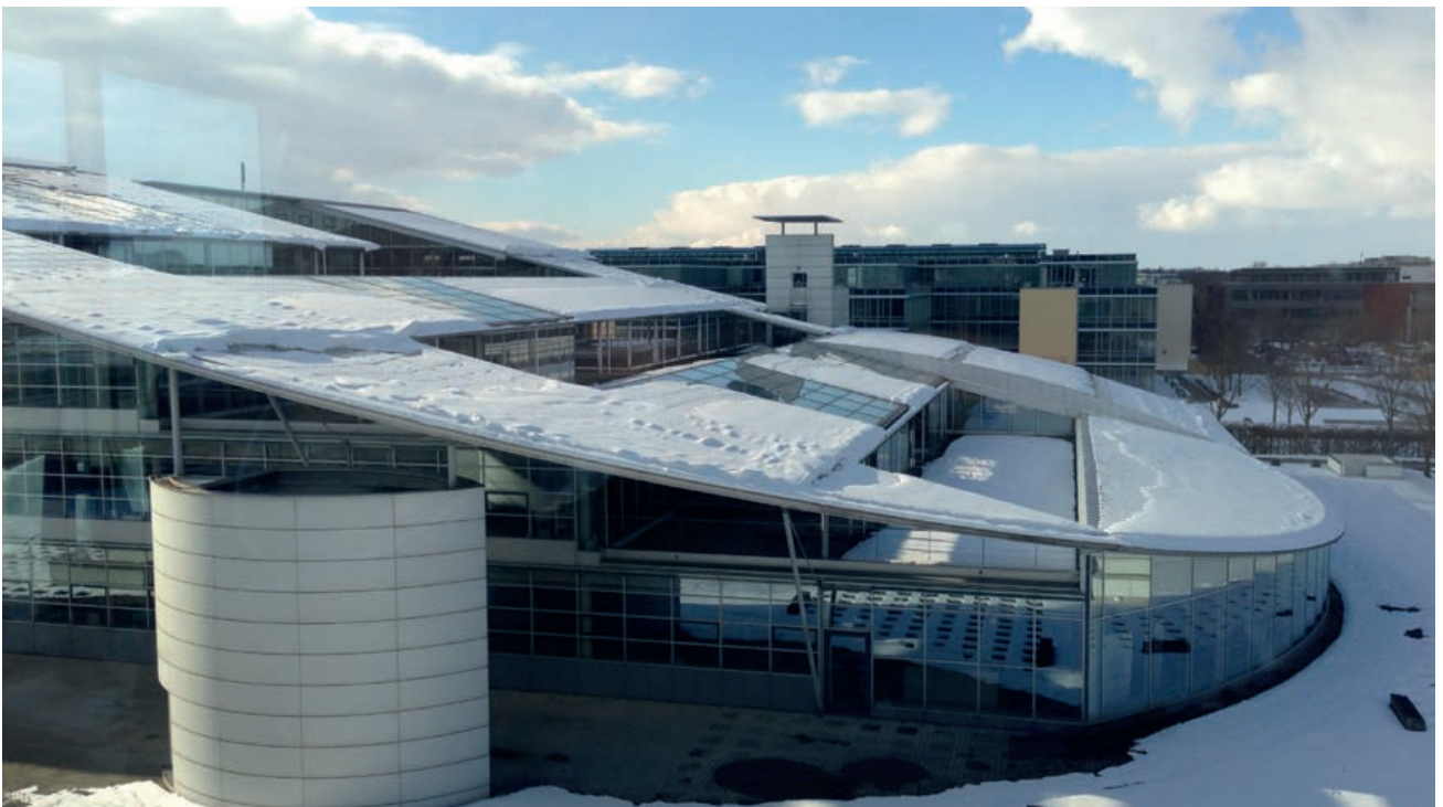
Edificio de NETMA nevado
