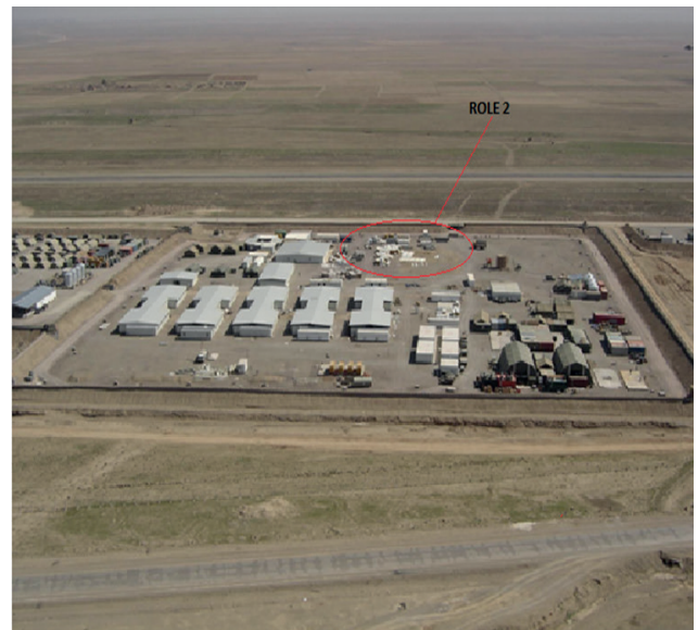
Construcción de Role 2 en contenedores (año 2006).
