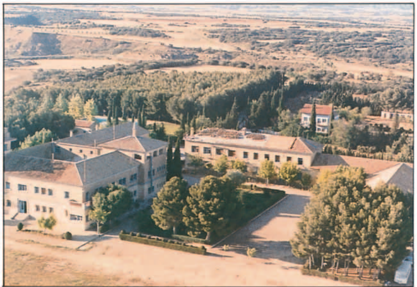
Las edificaciones de la Escuela durante la remodelación efectuado en 1987.
