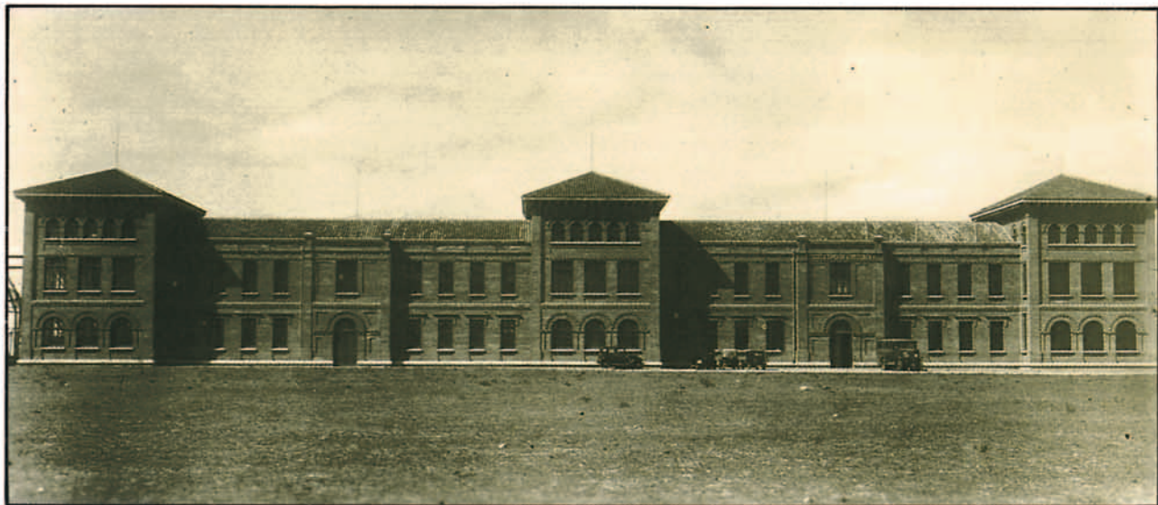
Este histórico edificio situado en Cuatro Vientos albergó a la Escuela Superior de Acrotécnica (1930), Academia Militar de Ingenieros Aeronáuticos y en la actualidad Escuela de Transmisiones.
