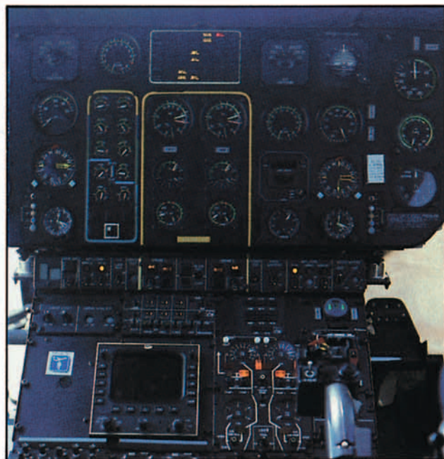
La cabina del Superpuma está dotada de instrumentos y mandos convencionales.
