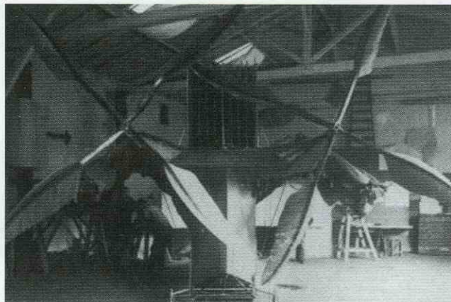
El Avion III en el taller de la rue Jasmin de París. Destaca el tamaño de las hélices y del condensador.
