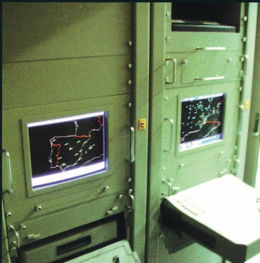
Vista parcial del shelter de control local del radar Lanza.
