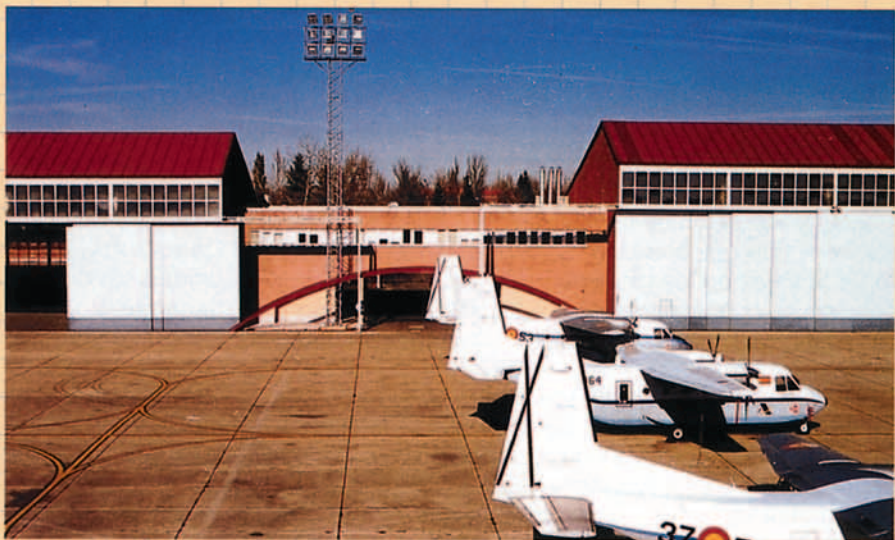
Cuerpo central. Oficinas de mantenimiento.
