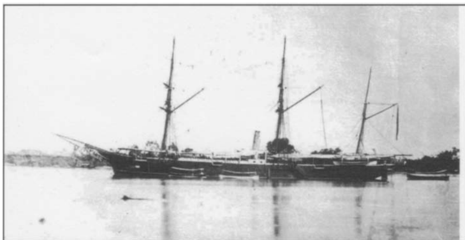
Goleta de hélice Santa Filomena , de 510 toneladas de desplazamiento, máquinas de 100 c.v. nominales, que le proporcionaban una velocidad de 8 nudos, y un armamento de dos cañones rayados de 16 cm y uno de 12 cm. Fotografía del libro Buques de vapor de la Armada española . J. Lledó Calabug.
