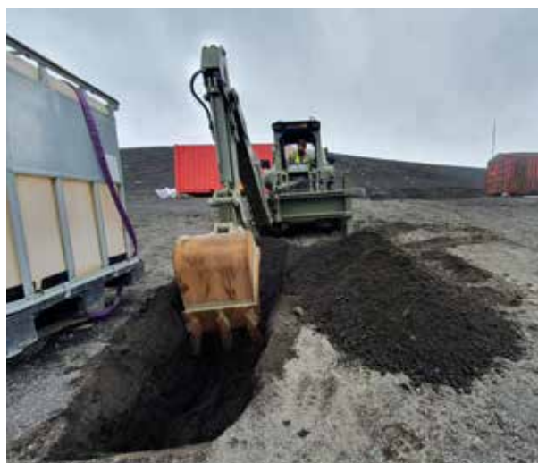
Tareas de nivelación para la colocación de contenedores y de realización de zanjas
