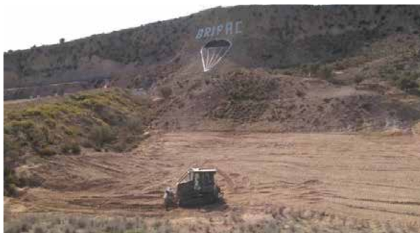
Desmonte del terreno para reducir la diferencia de cota
