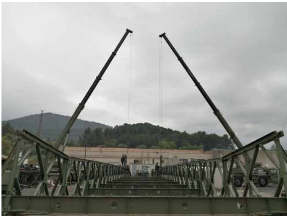
Trabajo de dos (2) grúas Luna AT 35/32 en paralelo
