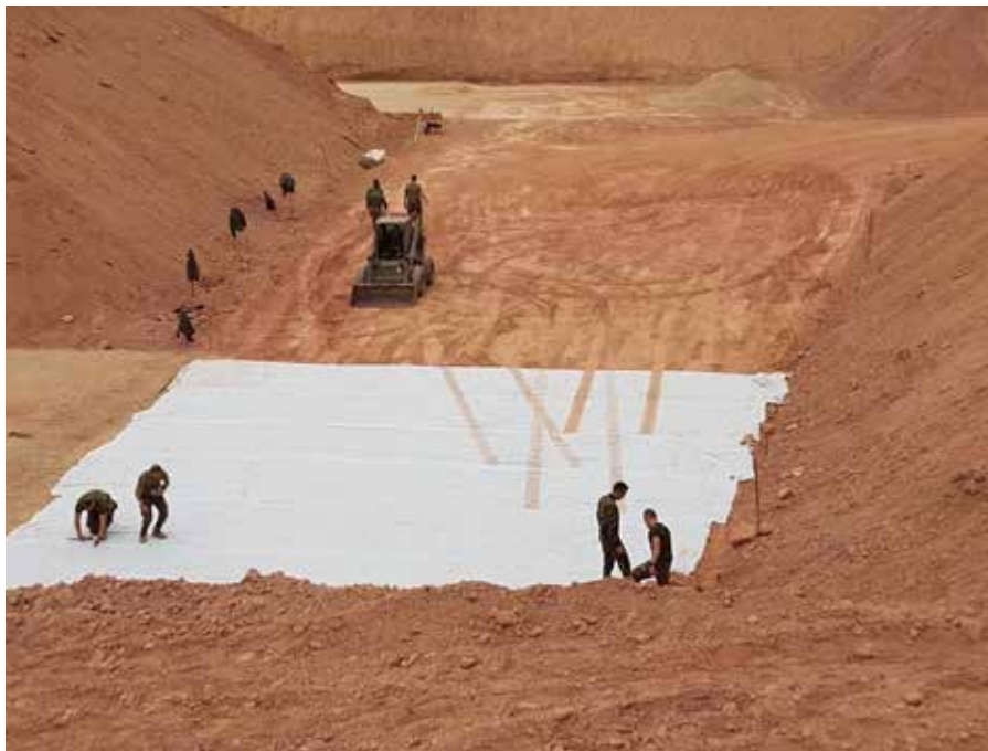
Extendido del geotextil dentro del foso
