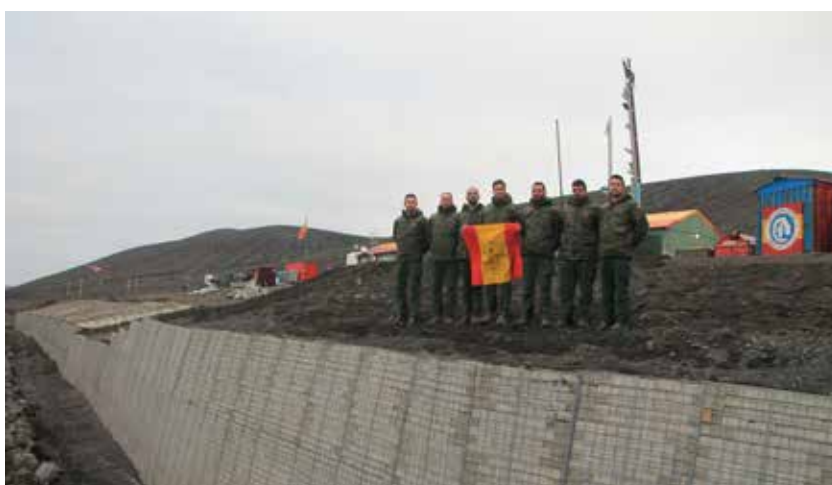
Personal REI 11 al finalizar los trabajos asignados
