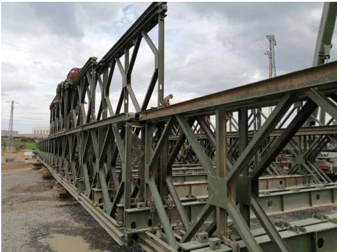
Trabajos en altura. Colocación de paneles y arriostramientos superiores
