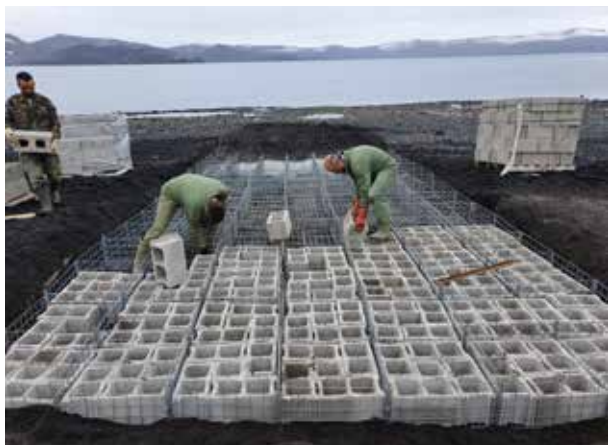
Ejecución Plataforma de descarga
