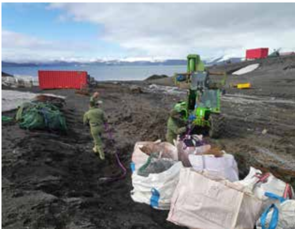
Clasificación de residuos generados y retirada de los antiguos gaviones
