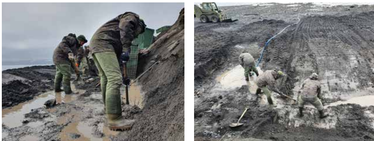
Trabajos de los equipos realizando la cimentación
