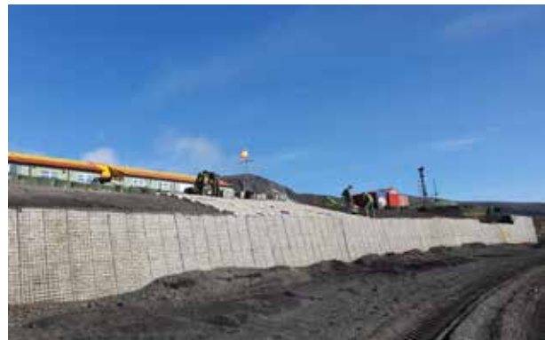
Ejecución manta de hormigón
