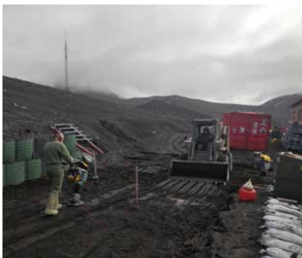
Tareas de nivelación para la colocación de contenedores y de realización de zanjas
