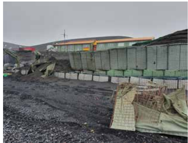
Clasificación de residuos generados y retirada de los antiguos gaviones
