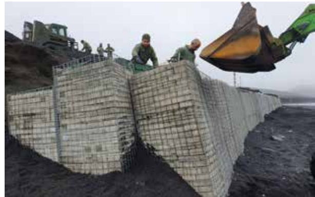
Inclinación y trabajos de relleno de trasdosado
