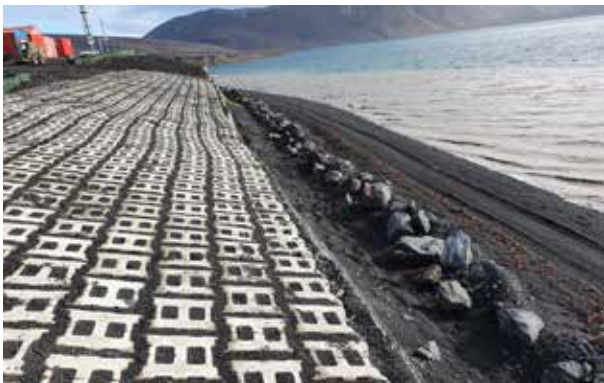
Ejecución manta de hormigón
