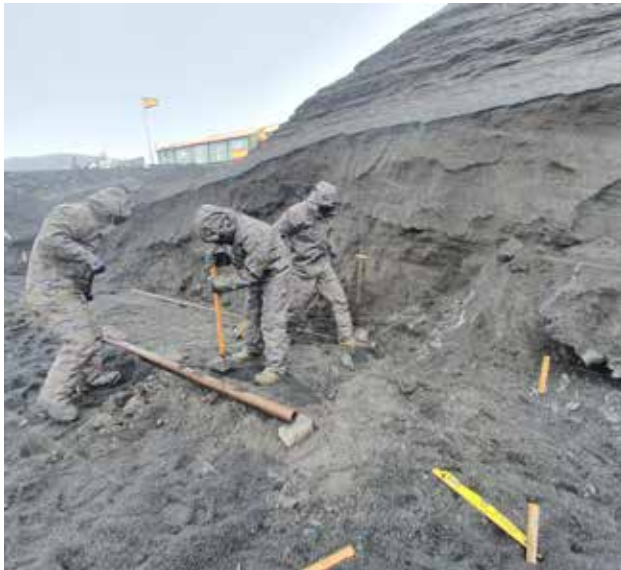
Condiciones extremas de climatológicas durante la realización de los trabajos
