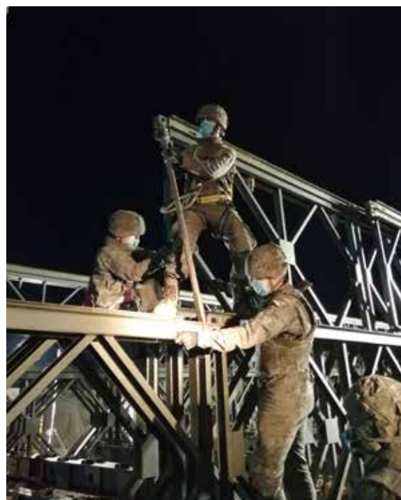
Colocación de paneles en arco nocturno
