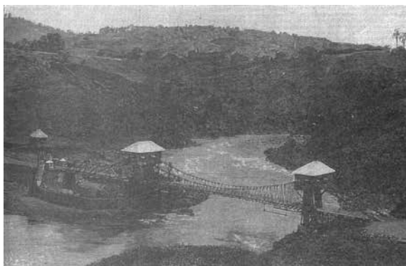
Islas Filipinas. La Campaña de Mindanao. Puente colgante sobre el Río Agus, construido bajo la dirección del Comandante de Ingenieros D. Rafael Ravana
