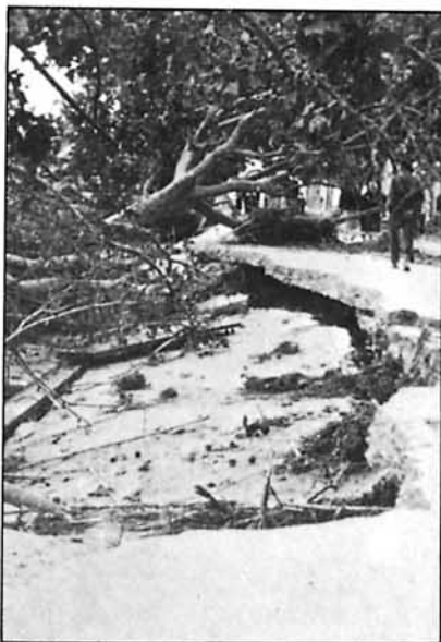
Este socavón produjo la cascada que arrastró a Bautista
