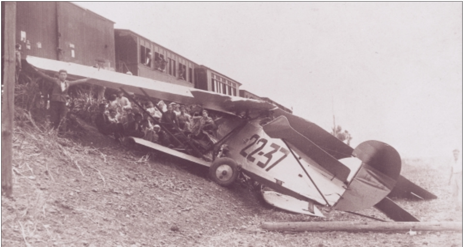
Accidente ocurrido en la proximidades de Lora del Río el 20 de mayo de 1930. El capitán Carlos Martínez- Vara de Rey pilotaba el Loring R-III, 22-37, con destino a Tablada, cuando se vio obligado a realizar un aterrizaje de emergencia por avería de mandos, quedándose en el talud a punto de interceptar la vía del tren.
