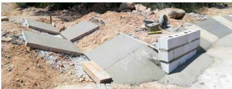
Figura 10. Cuneta en construcción
