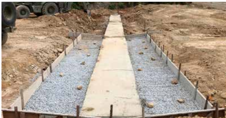
Figura 9. Paso de agua en construcción
