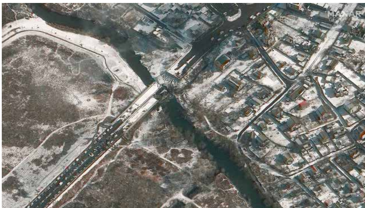
Figura 7. Puente destruido en Irpin (Ucrania)
