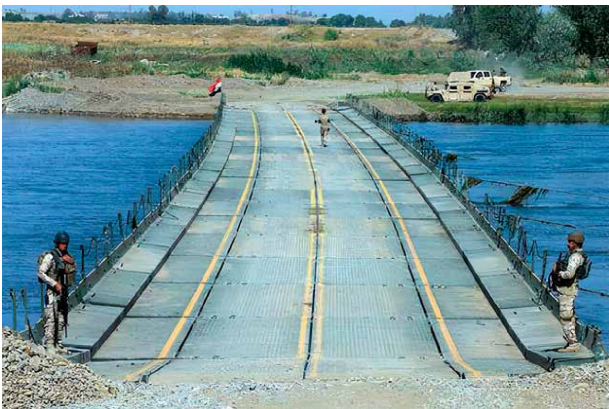
Figura 6. Puente de Pontones (tipo Ribbon) sobre el río Tigris en Mosul
