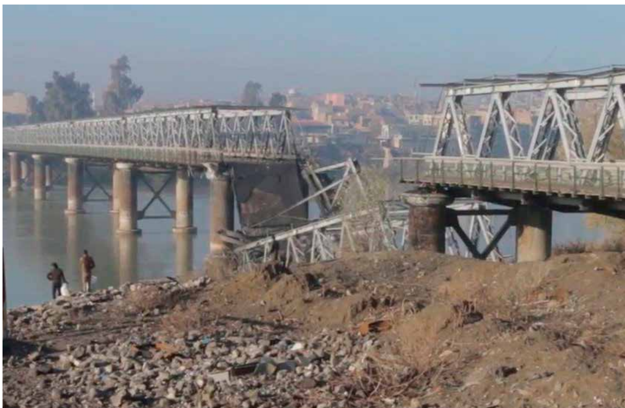
Figura 4. Old Bridge en Mosul
