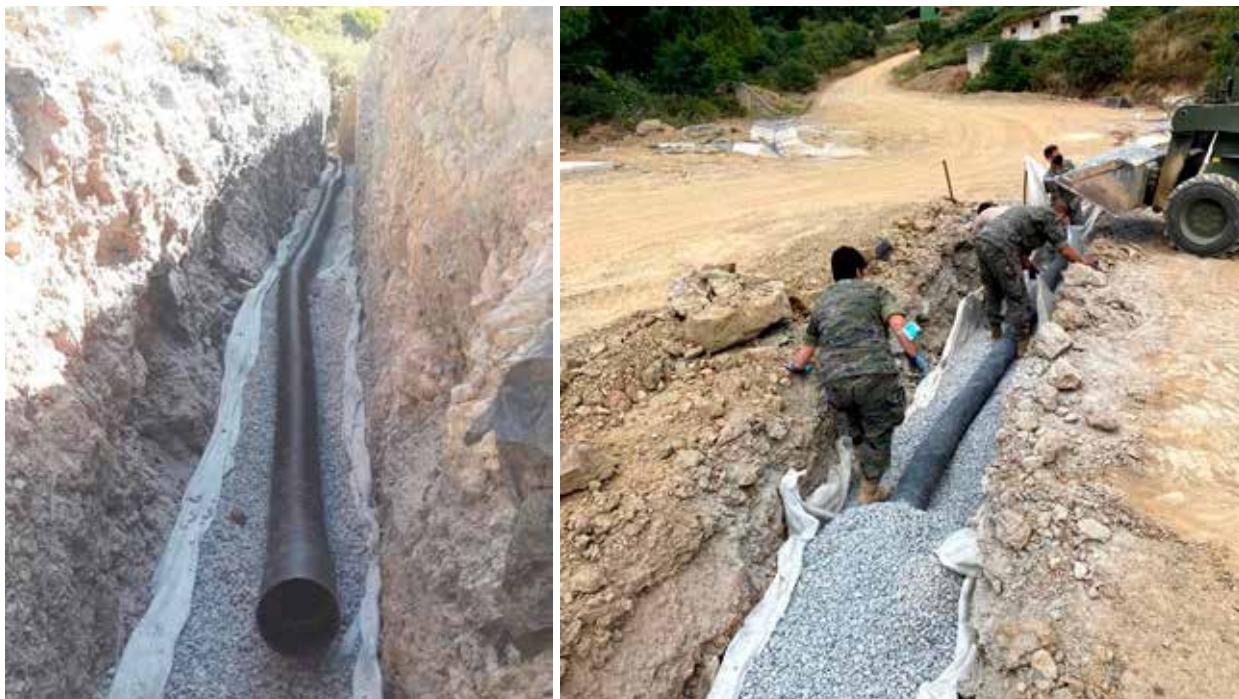
Figuras 11 y 12. Instalación de tubo drenante
