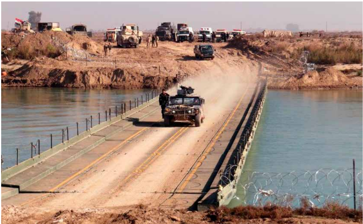
Figura 3. Puente de Pontones (tipo Ribbon) sobre el Canal de Warrar en Ramadi
