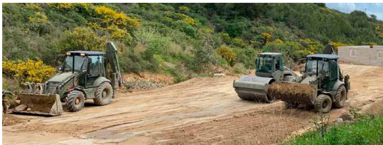
Figura 1. Retro-excavadoras y rodillo vibrante trabajando
