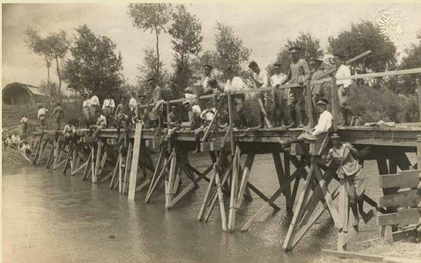
CADETES DE LA ACADEMIA DE GUADALAJARA CONSTRUYENDO UN PUENTE DE MADERA (GUADALAJARA, 1906)
