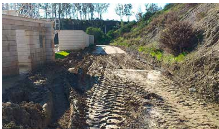
Figuras 5 y 6. Terreno limoso después de lluvias
