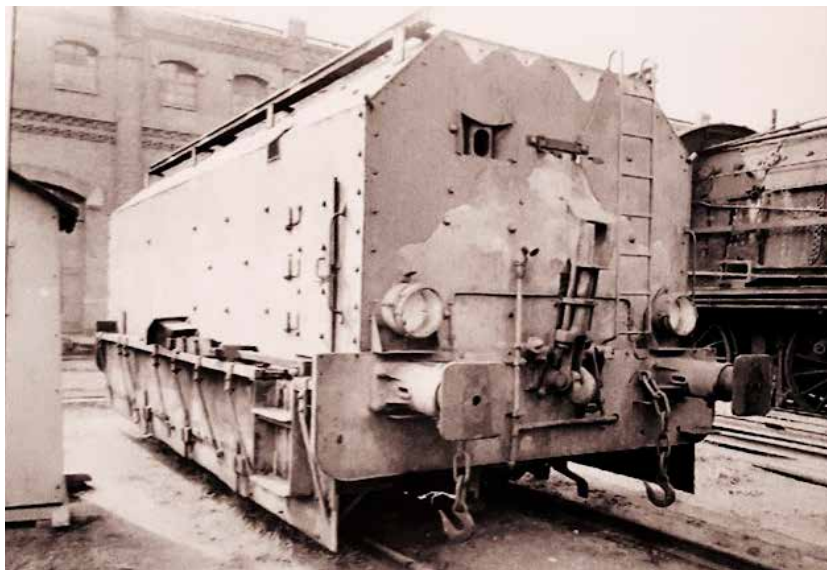
Figura 5. Locomotora MTM diésel blindada. Fuente: Trenes y tiempo
