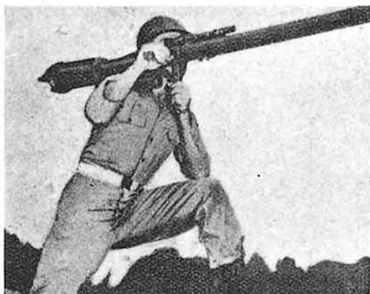
Cañón americano de 57 mm., que, por no tener retroceso, puede dispararse en cualquier posición. Lanza proyectiles de un kilogramo, con alcance de 3.200 metros.
