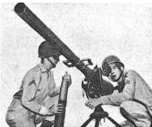
Cañón M-20, de 75 mm., también sin retroceso. Pesa sólo 50 kgs. y puede disparar proyectiles de 6,300 kgs. a más de seis kilómetros de distancia.
