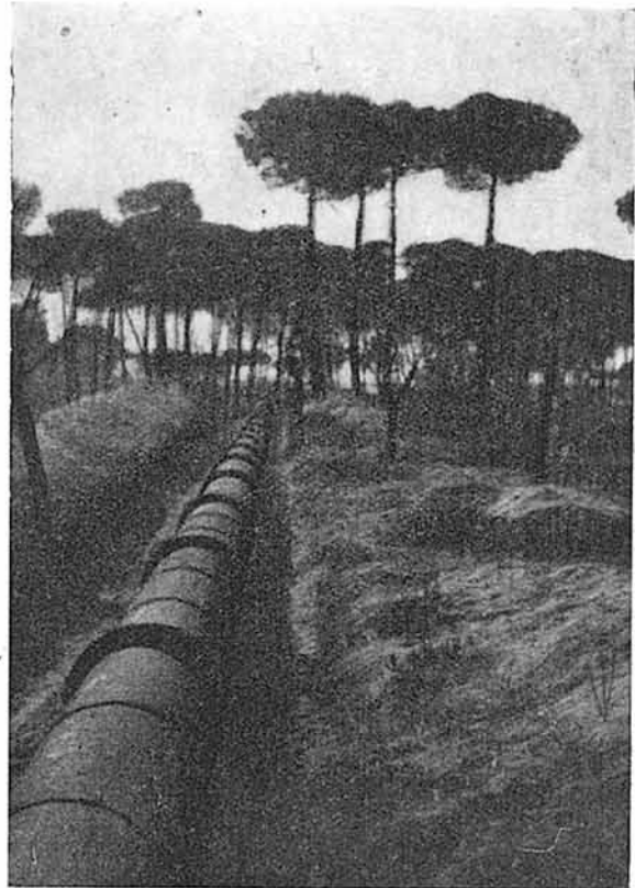
Tubería de impulsión de arenas del dragado.
