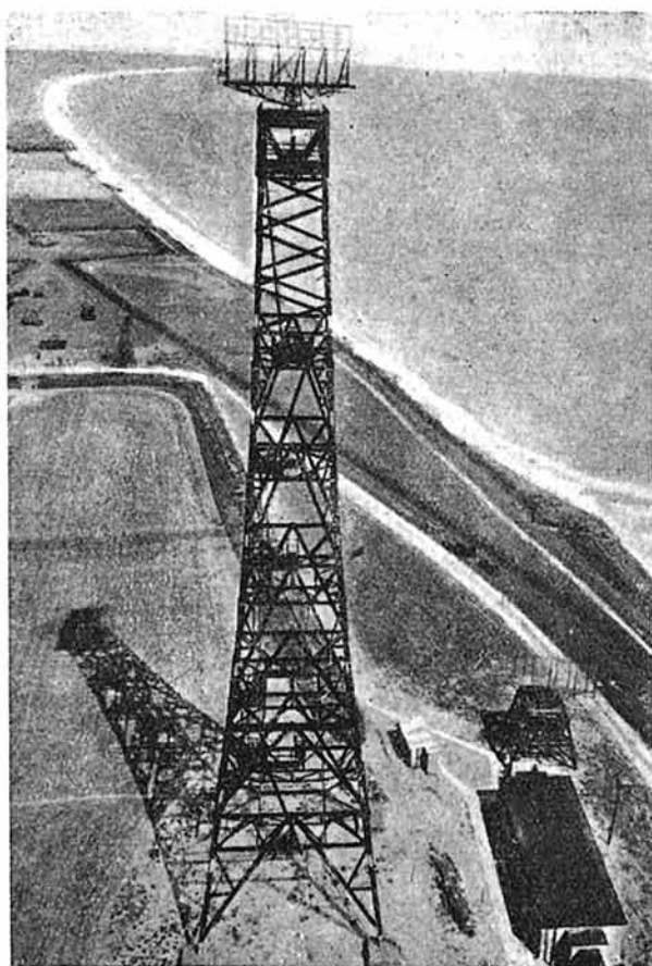
Radio detectora de las que constituían la "Chain Home" (= cadena de casa) que defendía la costa inglesa. La alta torre tiene por objeto llegar a descubrir a gran distancia, por bajo que efectúe el vuelo el avión enemigo.
