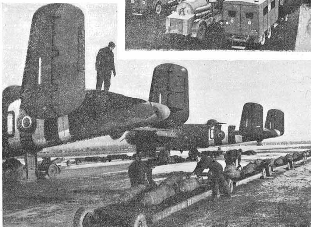
b) Municionamiento de bombas.
