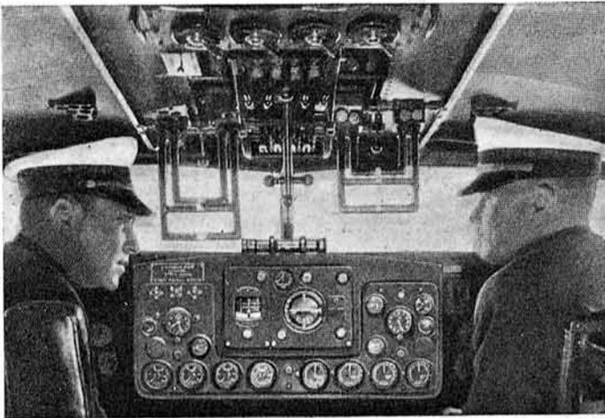
Puesto de mando de un clipper, hidroavión tetramotor Sikorsky-S. 42, en la parte central del tablero destaca el piloto automático Sperry.
