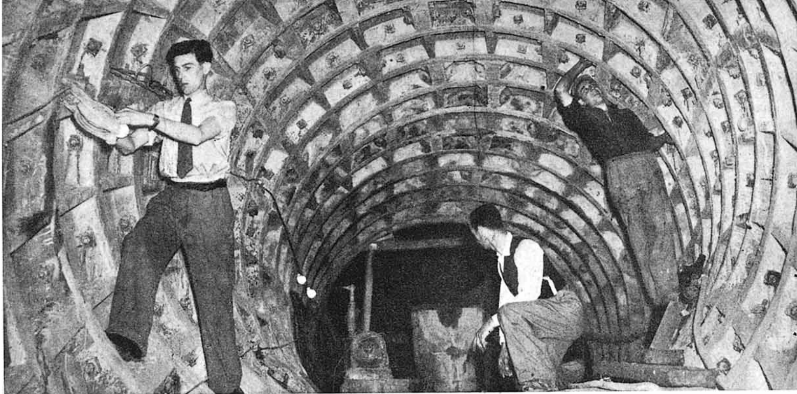
En Southwark (Inglaterra) se construye un refugio antiaéreo capaz para 14.000 personas. He aquí un detalle de construcción en uno de los túneles del mismo.
