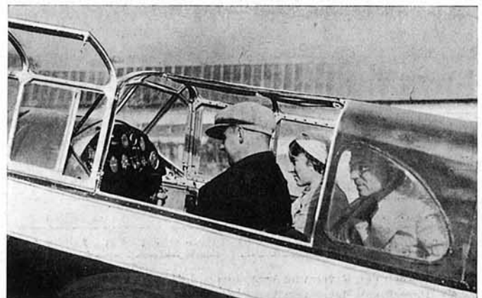
Cabina del triplaza alemán de turismo « K. L. 32 », con motor Siemens , 130/150 cv.
