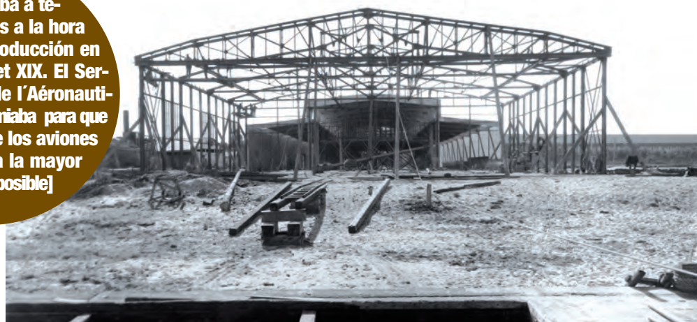
La factoría de Cádiz en construcción.
