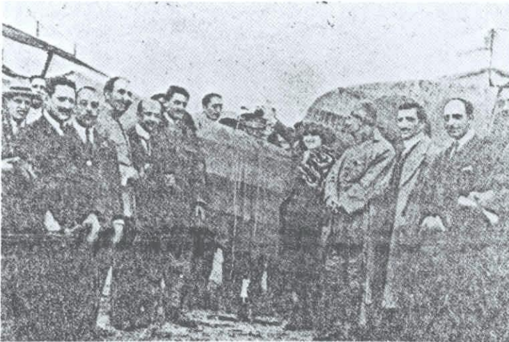
Bautizo de la línea aérea en Málaga el 1 de abril de 1920.
