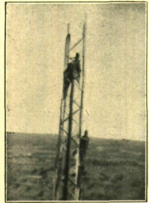
Haciendo un empalme en la línea de Sagunto.
