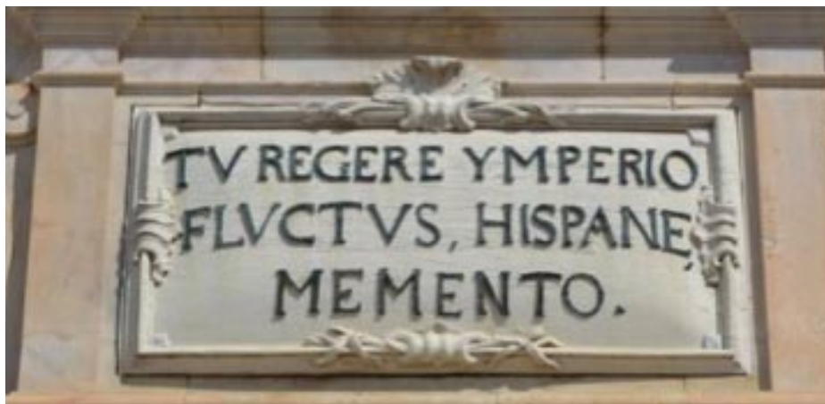
Puerta del mar del arsenal de La Carraca y detalles. F.: la autora
