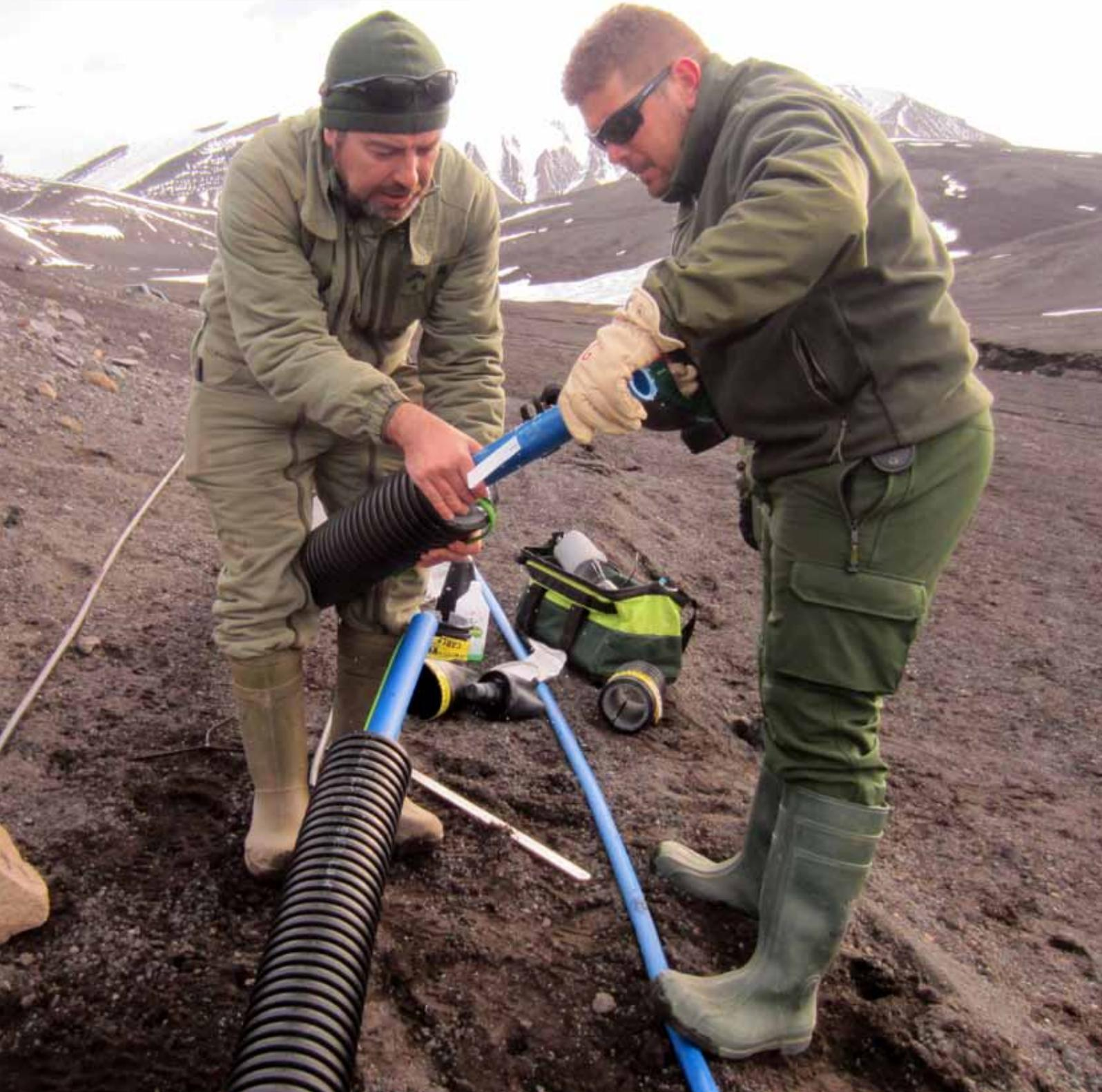
*Trabajos de montaje de una parte de la tubería calefactada en la isla Decepción*
