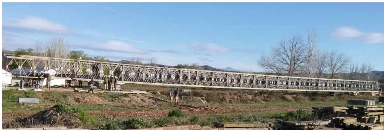
*Figura 1. – Fotografía del puente Mabey tomada durante su montaje en el RPEI*
