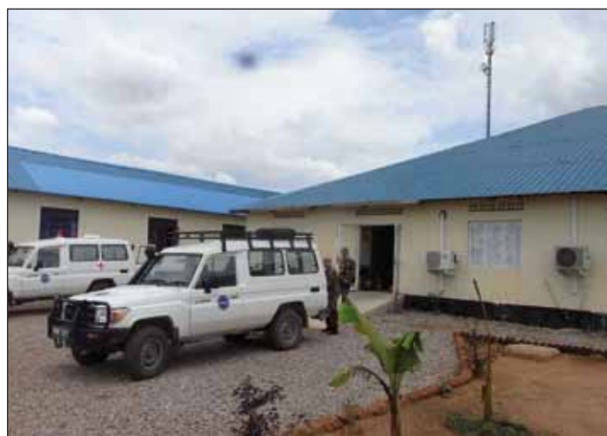
Figura 4. Instalaciones sanitarias de EUTM en el Campamento de Bihanga: Ambulancia y Roles 1 y 2.
