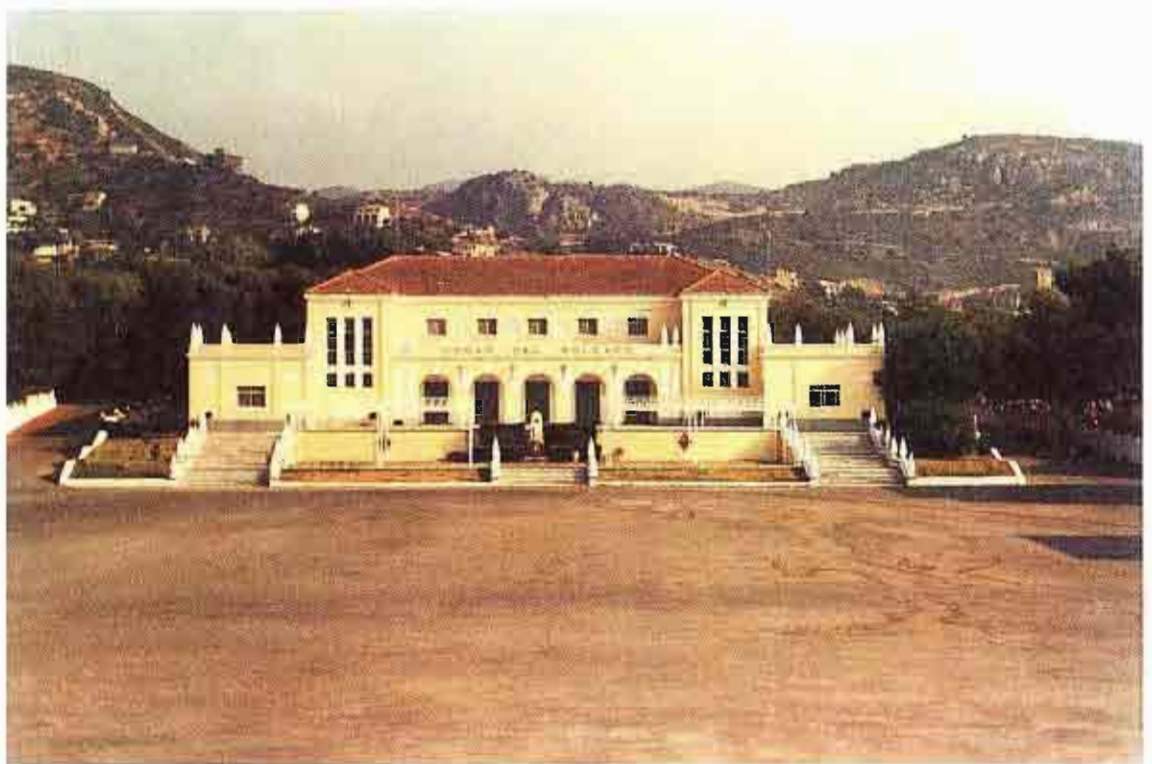
Edificio del Salón de Actos. Hogar del Soldado.
