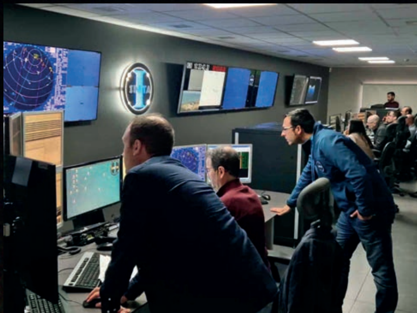
Centro de control
