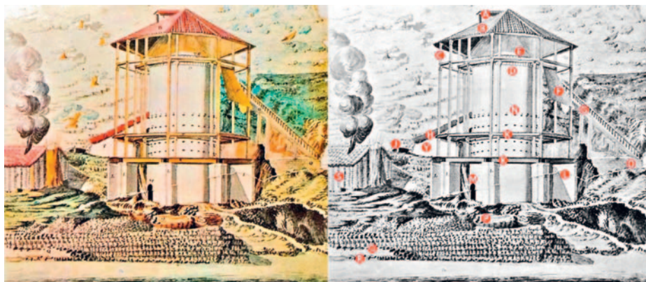
Fig. 13. Vista perspectiva del horno de La Riera, realizada el 3 de mayo de 1794, con indicación de los distintos elementos que lo componían: A , guardilla; B , tinglado; C , pilares de madera para sostener el tinglado y corredor; D , corredor superior de hierro; E , puerta para cargar el horno; F , tinglado de madera para defender los vientos y las aguas; G , rampa de madera por donde sube el carbón; H , cañería del condensador; I , arco que la sostiene; J , primera arqueta del condensador; K , corredores para los ventiladores; L , columnas que sostienen los corredores y tinglados; M , puerta del cenicero; N , ventiladores; O , rampa de piedra para subir el carbón; P , una carbonera; Q , paredón que se está haciendo en sillería para conservar el terreno; R , malecón; S , fragua provisional para herramientas
