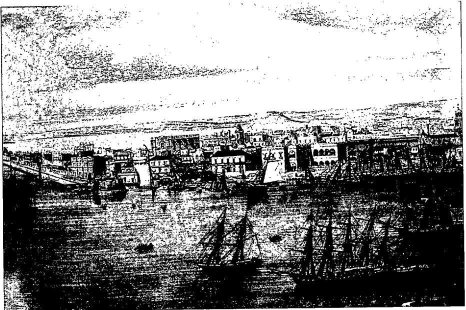
Vista de La Habana desde Casablanca, año 1848. En el centro, el edificio de la Comandancia General del Apostadero de La Habana. (Litografía de F. Mihale).
