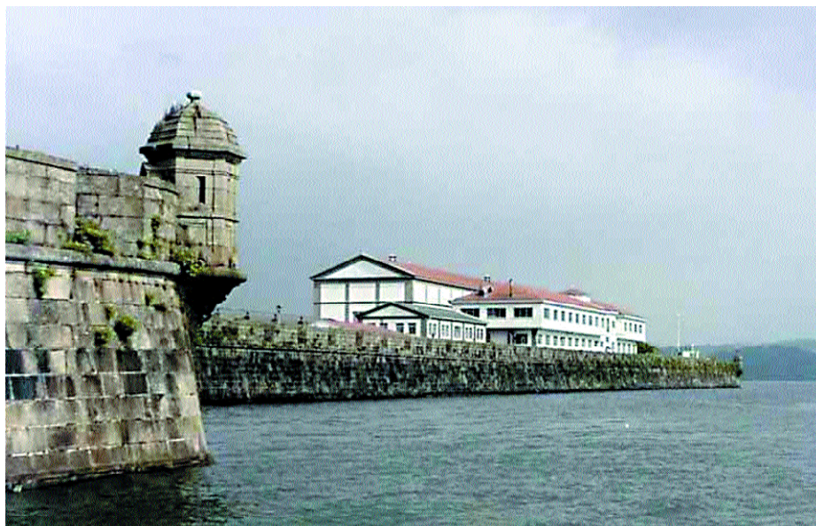
Dique de abrigo y batería de La Cortina.
