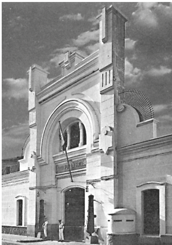
Fachada de la Prisión de Penas Aflictivas, diseñada por el arquitecto Celestino Aranguren.
