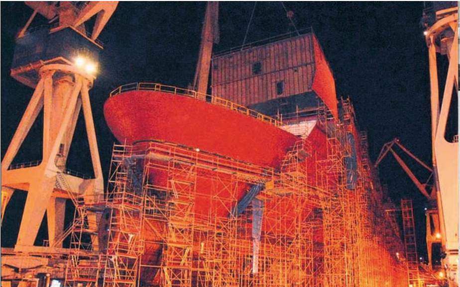
Estado de avance de la construcción en diciembre de 2007.
