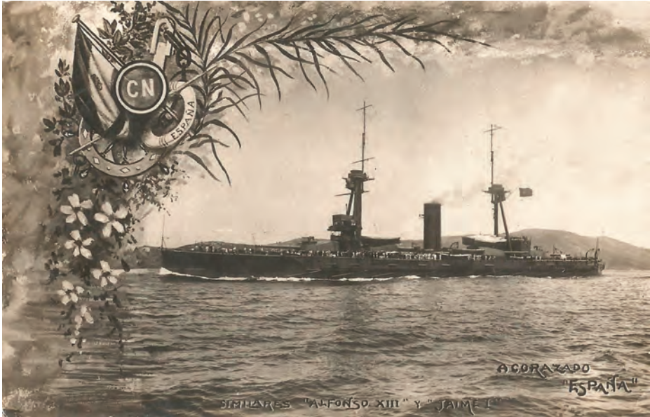
Postal de la Sociedad Española de Construcción Naval de Ferrol, donde fue construido el buque, que muestra al España navegando en una de sus primeras singladuras.
